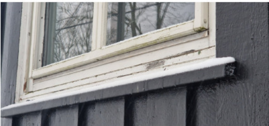
Vindu i 1 etg.
