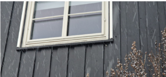
Vindu i 1 etg.
