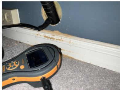
Hulltagning i vegg i kjellerstue, ingen unormal fukt.
